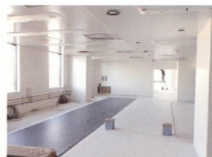
3階床施工状況
