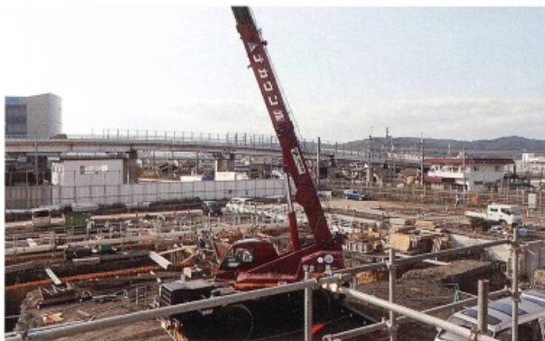
立体駐車場施工状況
