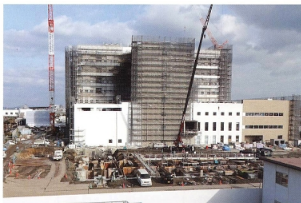
西側現場全景(11月上旬)
