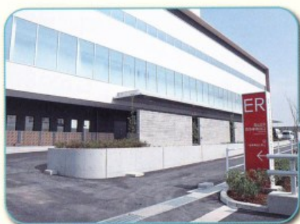
救急車専用ロータリー周辺（平成27年3月20日撮影）
