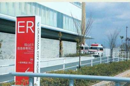
図9 「岡山ER」入口
